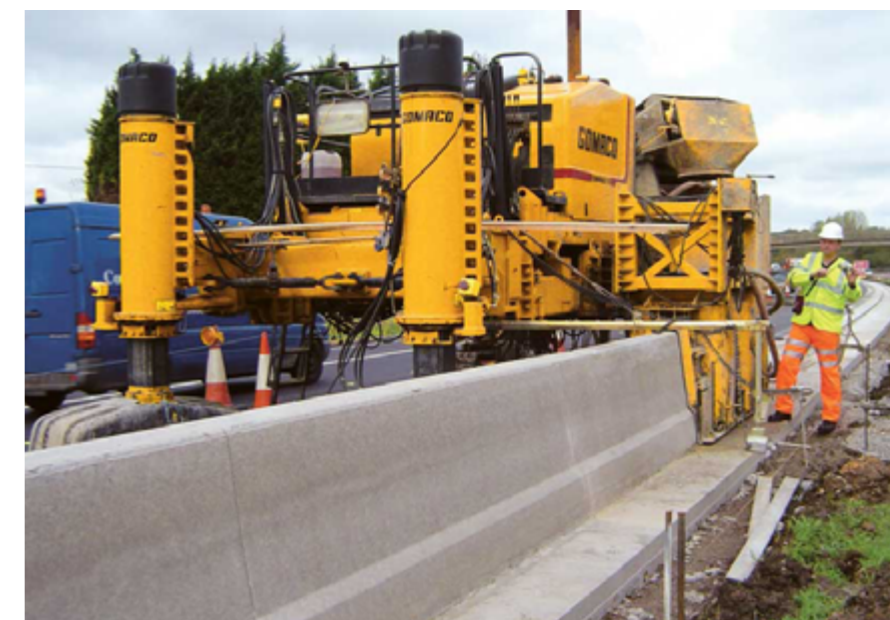
Slika 9: Primera slip-forming gradnje betonske varnostne ograje, pridobljeno z: https://www.gomaco.com/resources/commander_4t_barrier.html .
