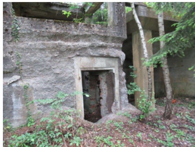
Slika 5: Sortirnica, ruševinska betonska zgradba pred vhodom rudnika Sitarjevec, fotografija: Mateja Golež, Arhiv ZAG.
