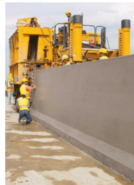
Slika 9: Primera slip-forming gradnje betonske varnostne ograje, pridobljeno z: https://www.gomaco.com/resources/commander_4t_barrier.html .
